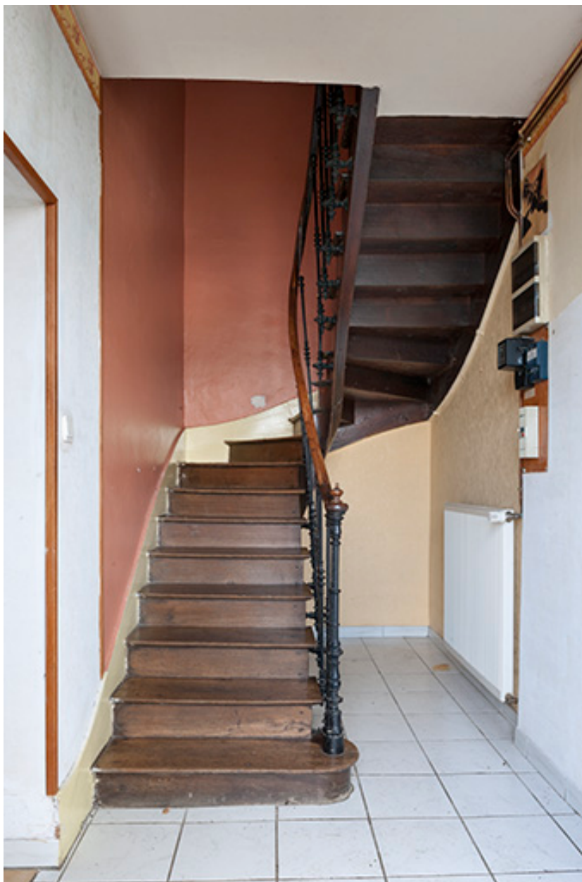
Escalier intérieur de la maison du barragiste à Montureux-lès-Baulay (70).
