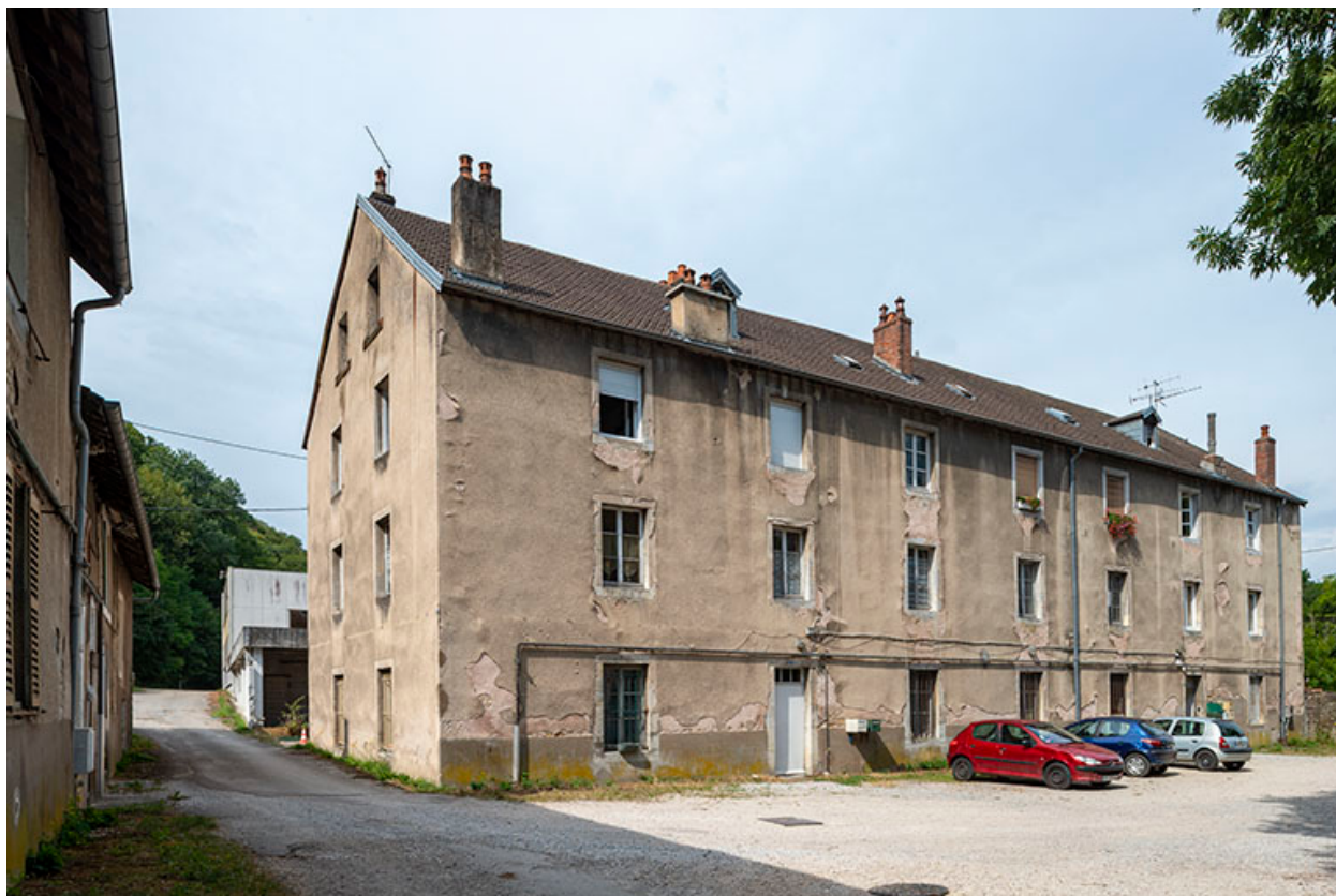
Logement ouvrier vu depuis la cour.
