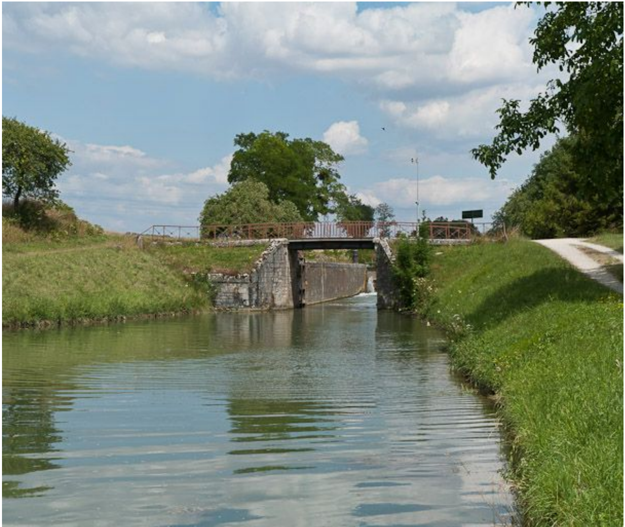
Vue du pont depuis l'aval.
