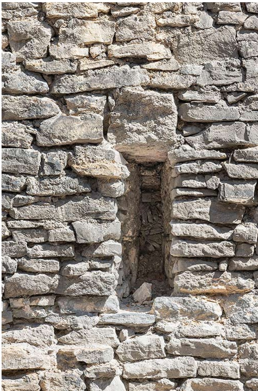
Détail d'une meurtrière, rue de Tivoli.
