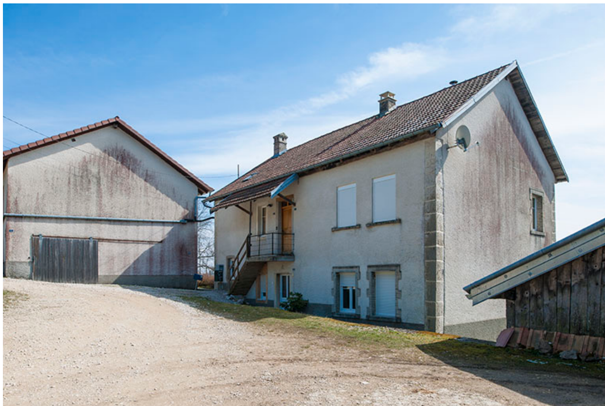
Atelier de fabrication et logement, côté cour.
