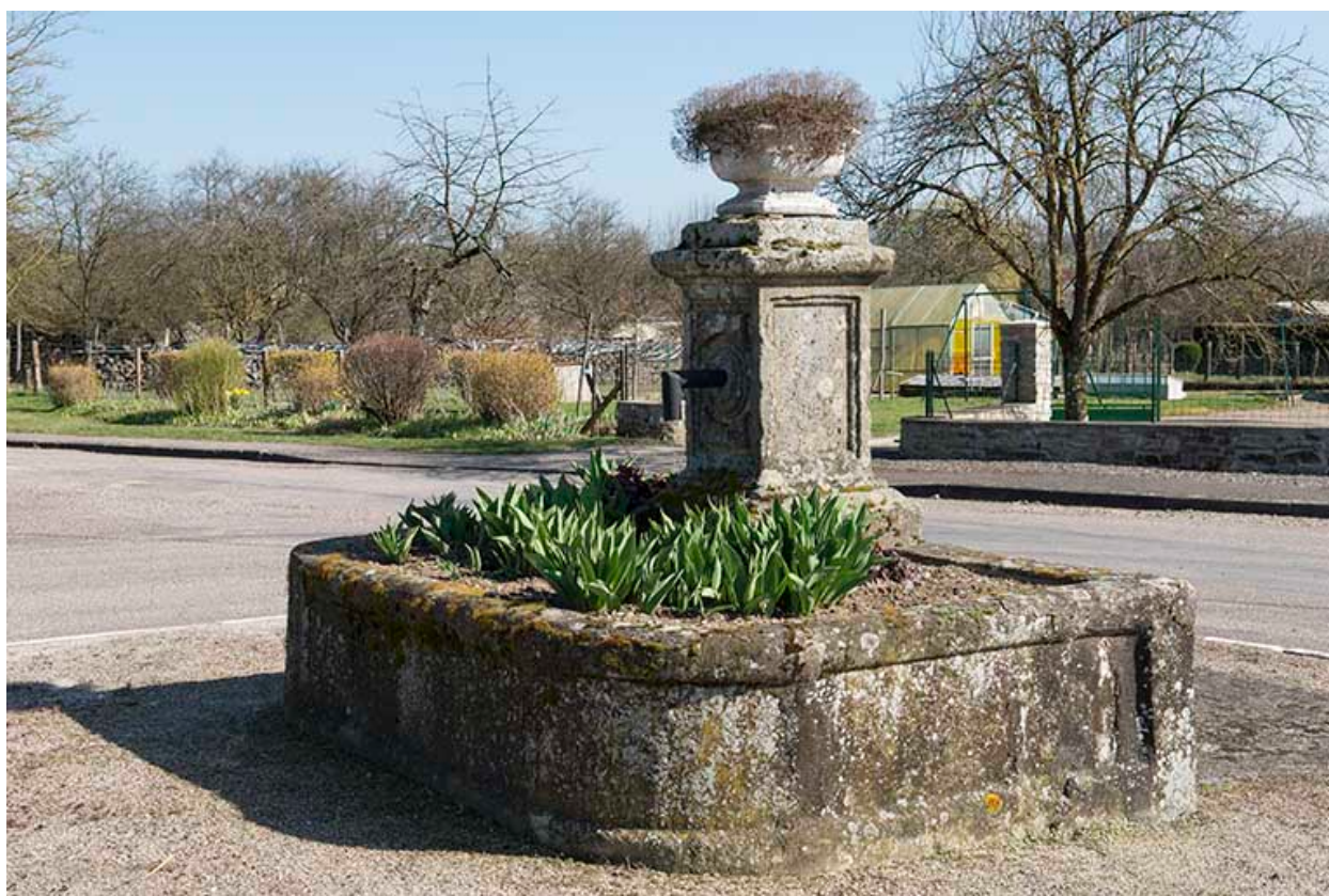
Le bassin maçonné de la fontaine.
