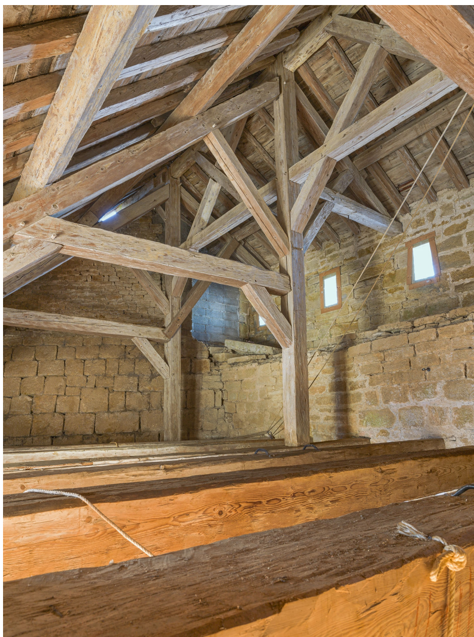
2e étage : détail de la charpente.
