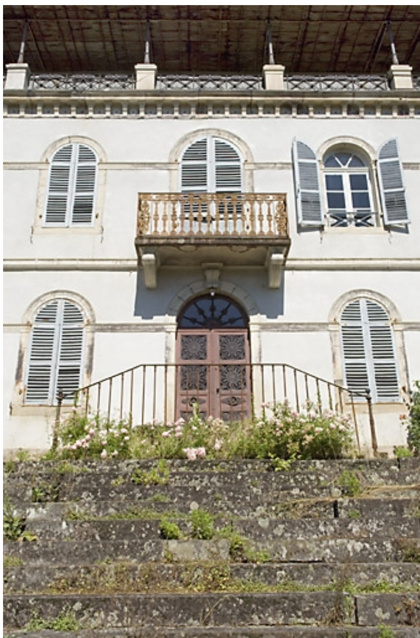
Logement patronal nord. Détail des travées centrales.
