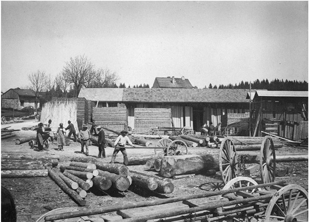
Scierie Paget puis Girardet, Saint-Laurent-en-Grandvaux (la Savine) : St Laurent. La scierie (chantier devant l'usine), 1898.
