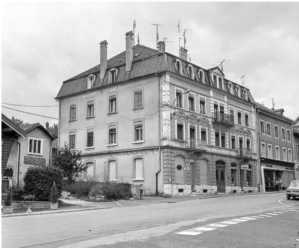
Façades antérieure et latérale gauche, en 1977.
