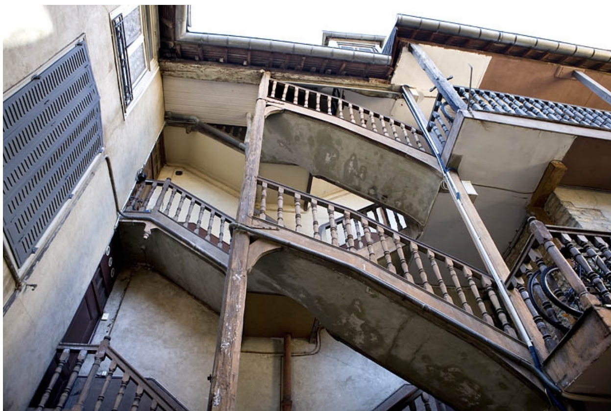
Détail de l'escalier à cage ouverte.
