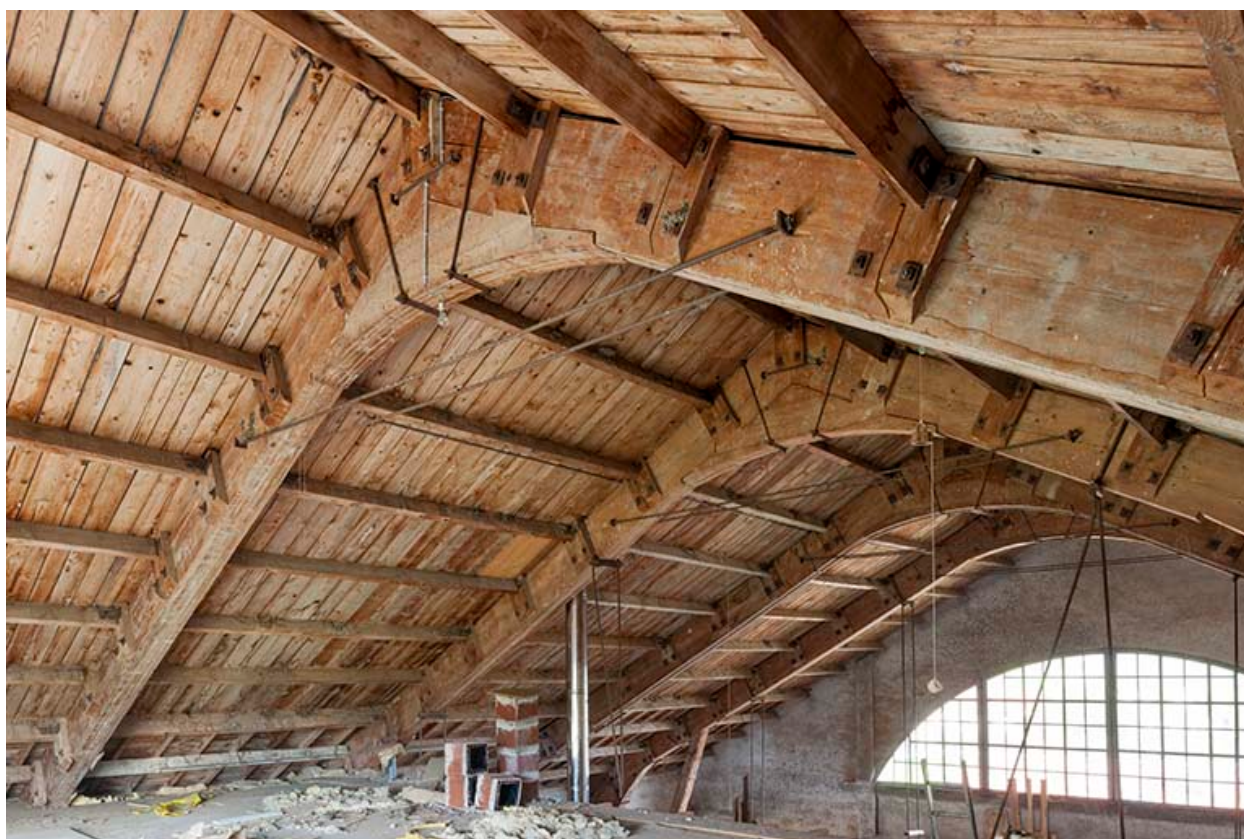
Scierie communale de Remoray-Boujeons. Charpente en bois lamellée-boulonnée.
