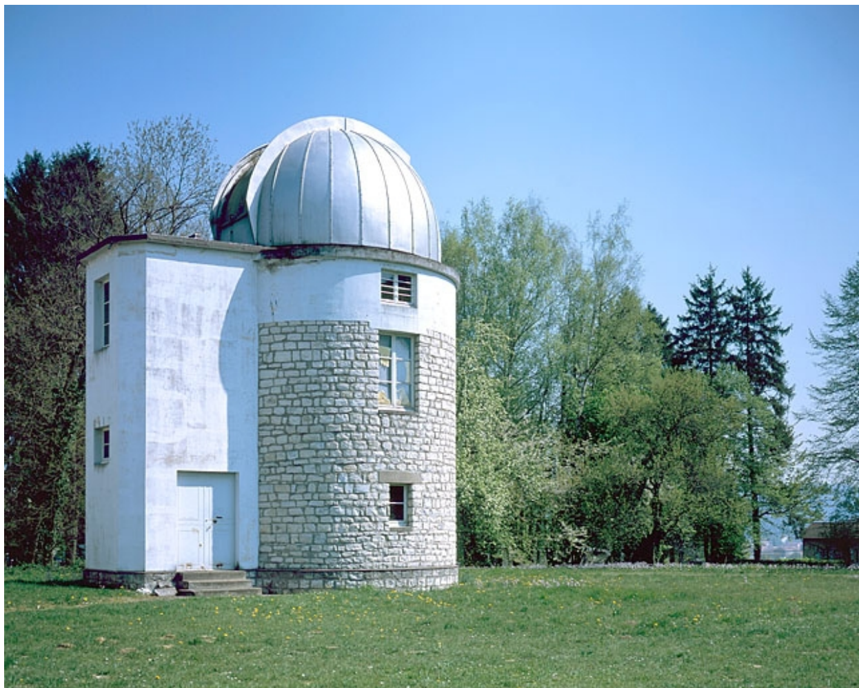
Vue d'ensemble, depuis l'ouest.
