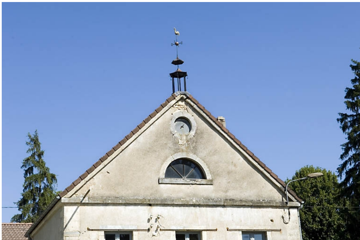
Fronton du bâtiment d'eau.
