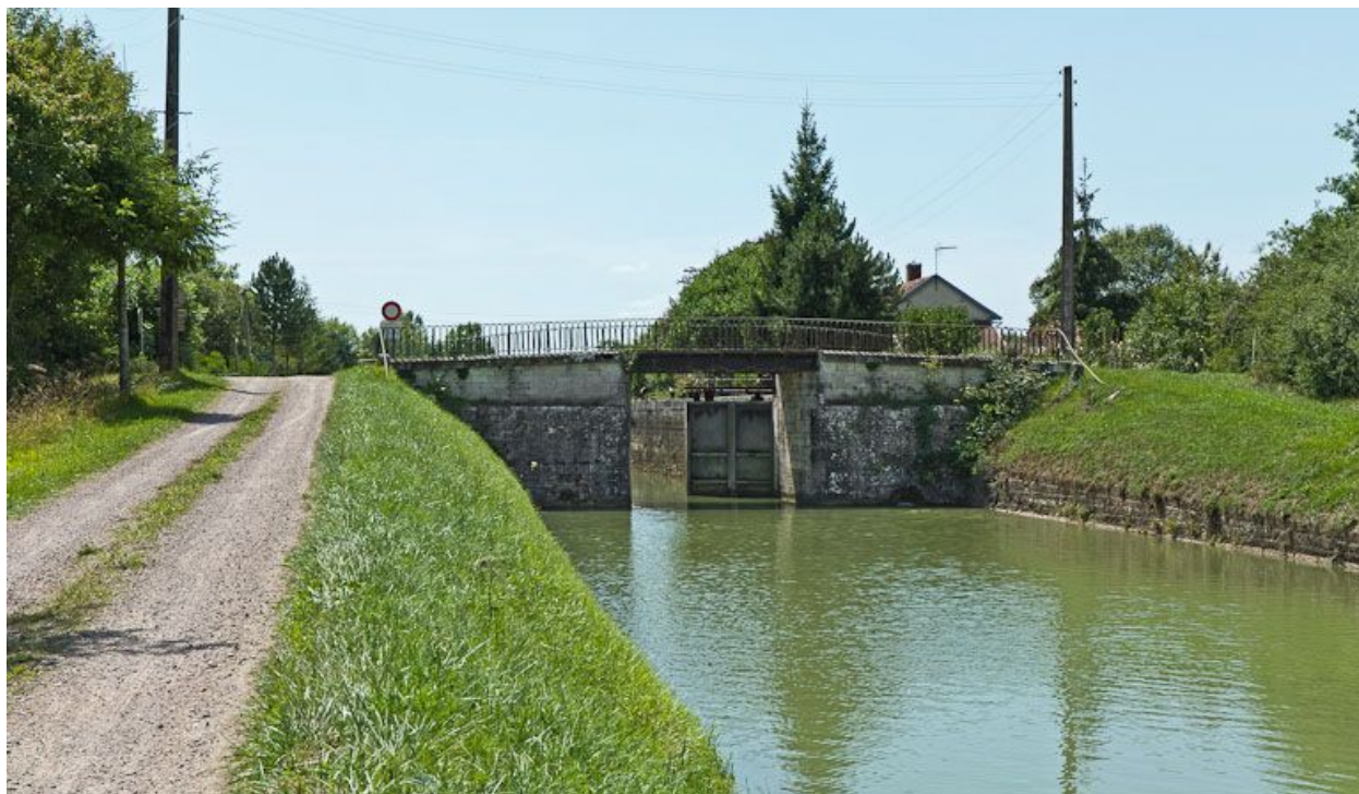
Vue du pont depuis l'aval.
