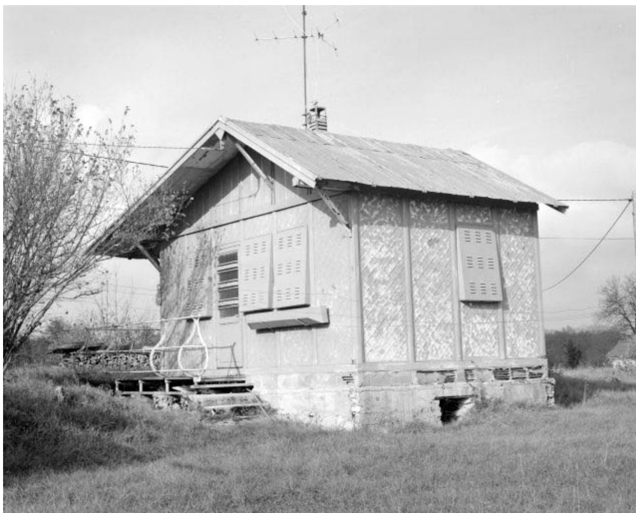
Façades latérale droite et postérieure.
