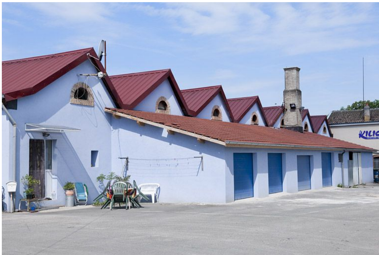
Pignons de l'atelier de fabrication.
