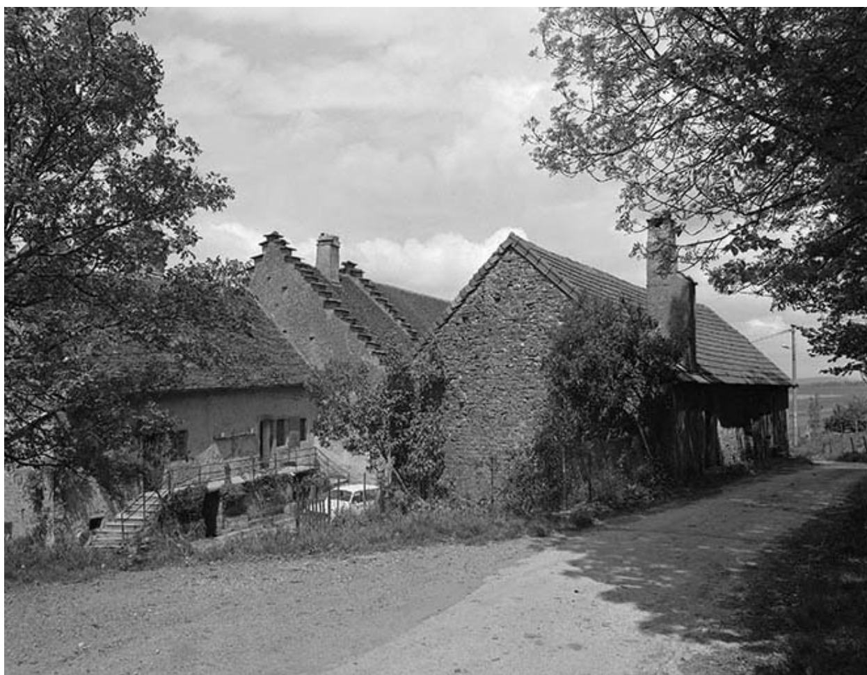
Ferme située chemin du Château.
