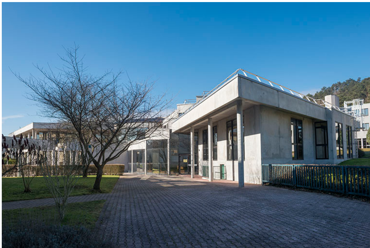
Angle nord-est de l'administration et façade est.
