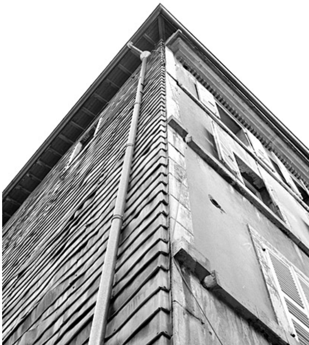
Angle des murs sud et est.
