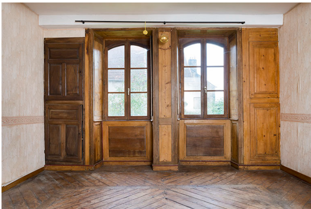
Détail des fenêtres ayant conservé leurs boiseries: plintes, encadrements, retours de fenêtres, volets intérieurs et placards
