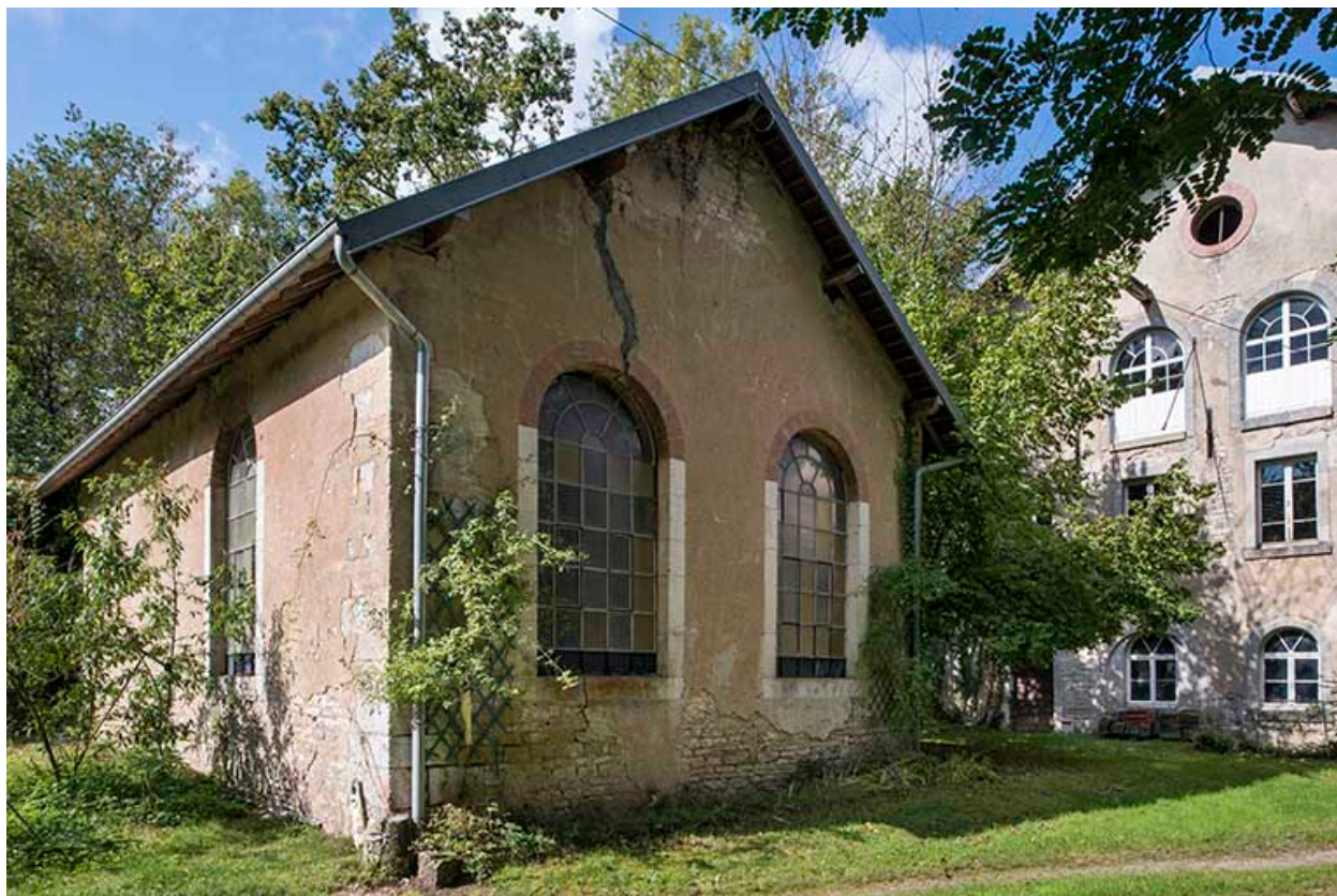
Salle de la machine à vapeur.
