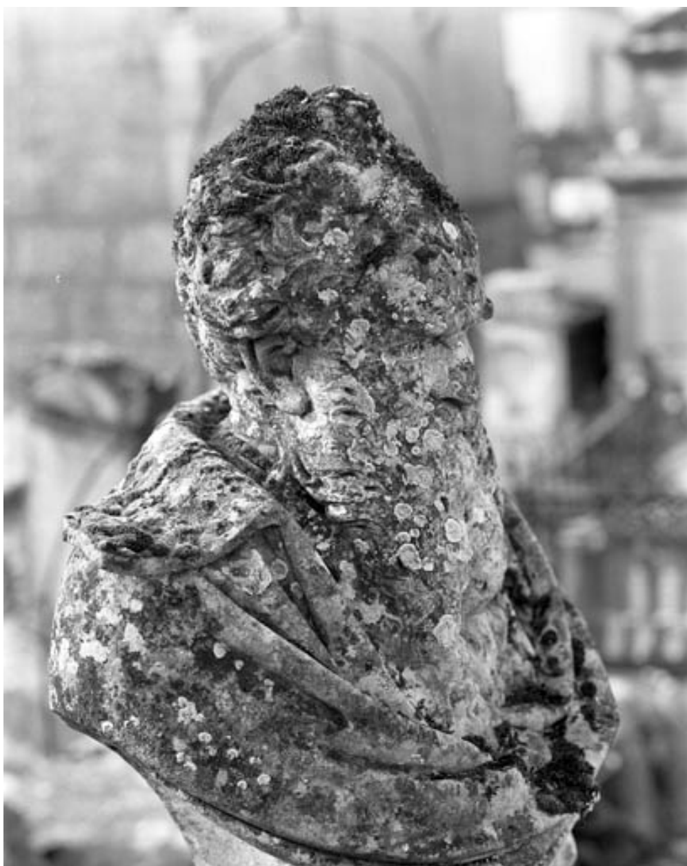
Détail de l'altération de la pierre sur le buste.
