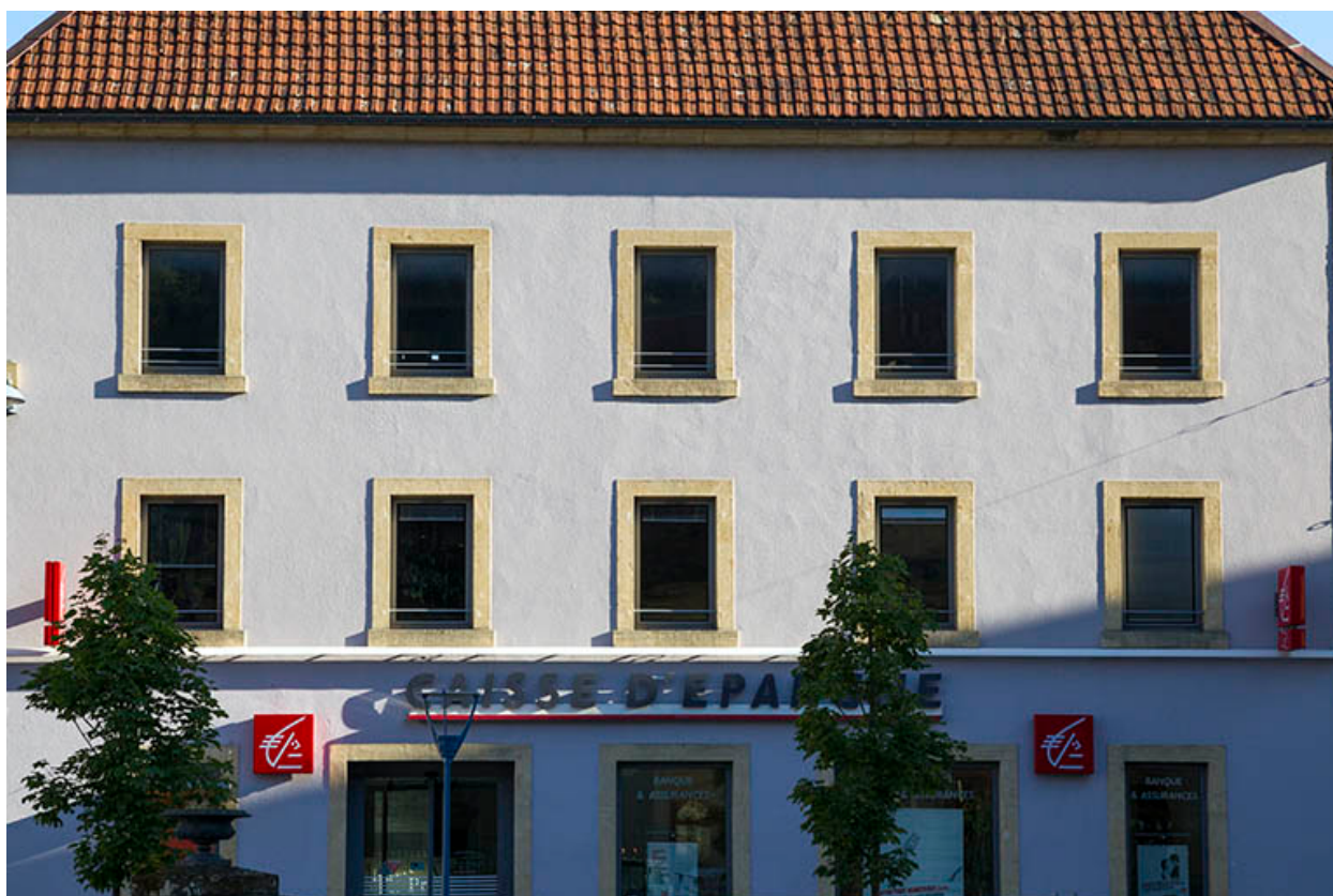
Façade antérieure : fenêtres des deux étages carrés.
