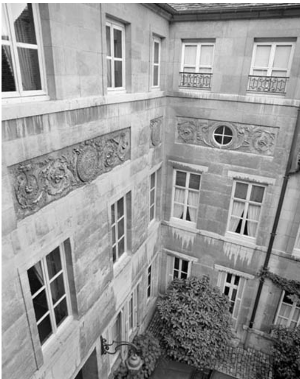
Façade sur cour depuis l'avant-corps gauche.
