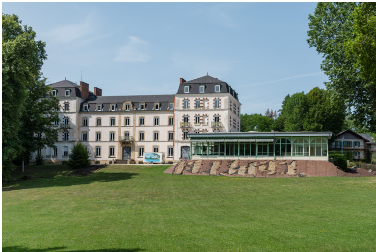
Façade sur le parc.
