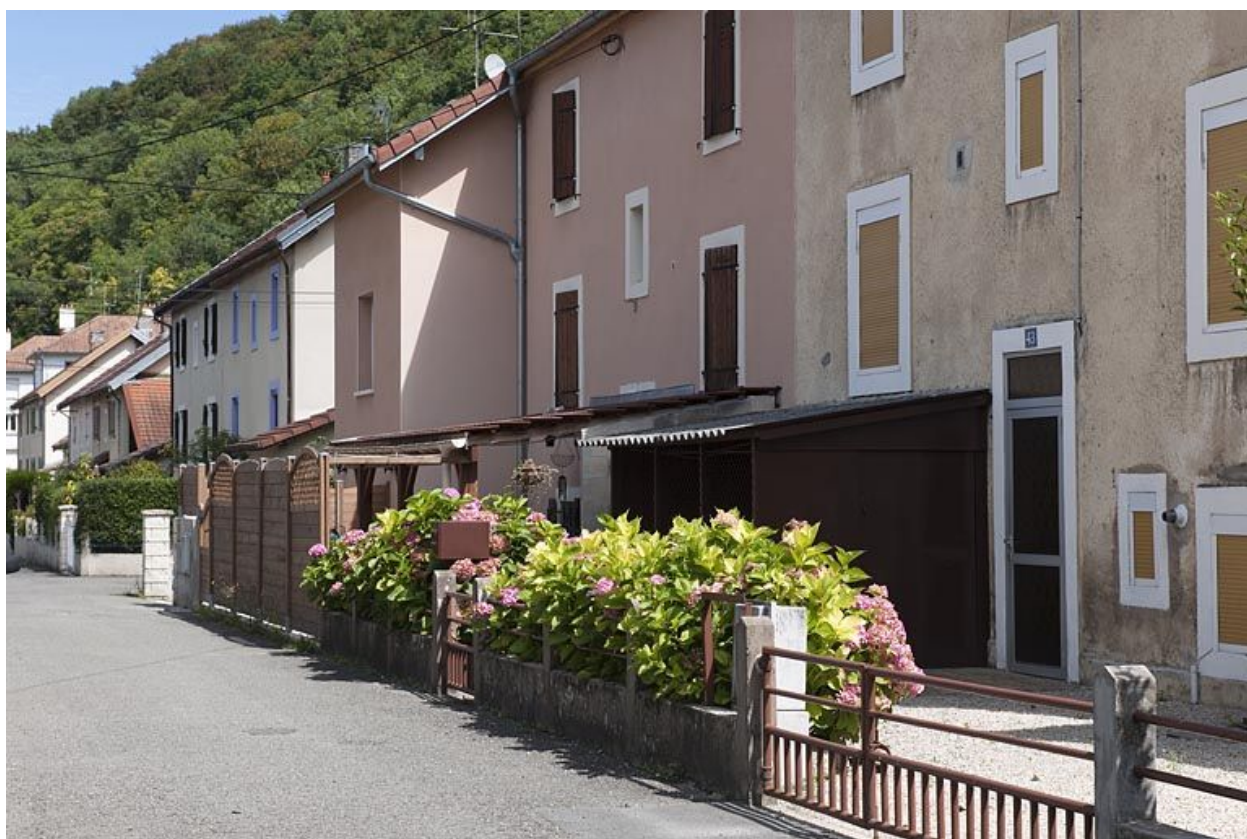
Façades ouest d'habitations ouvrières.
