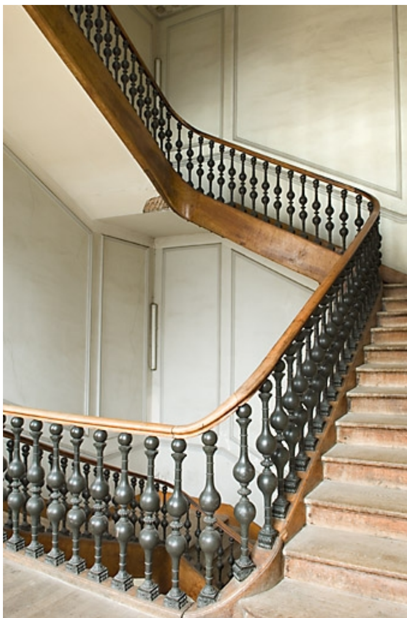
Escalier d'honneur : vue d'ensemble.
