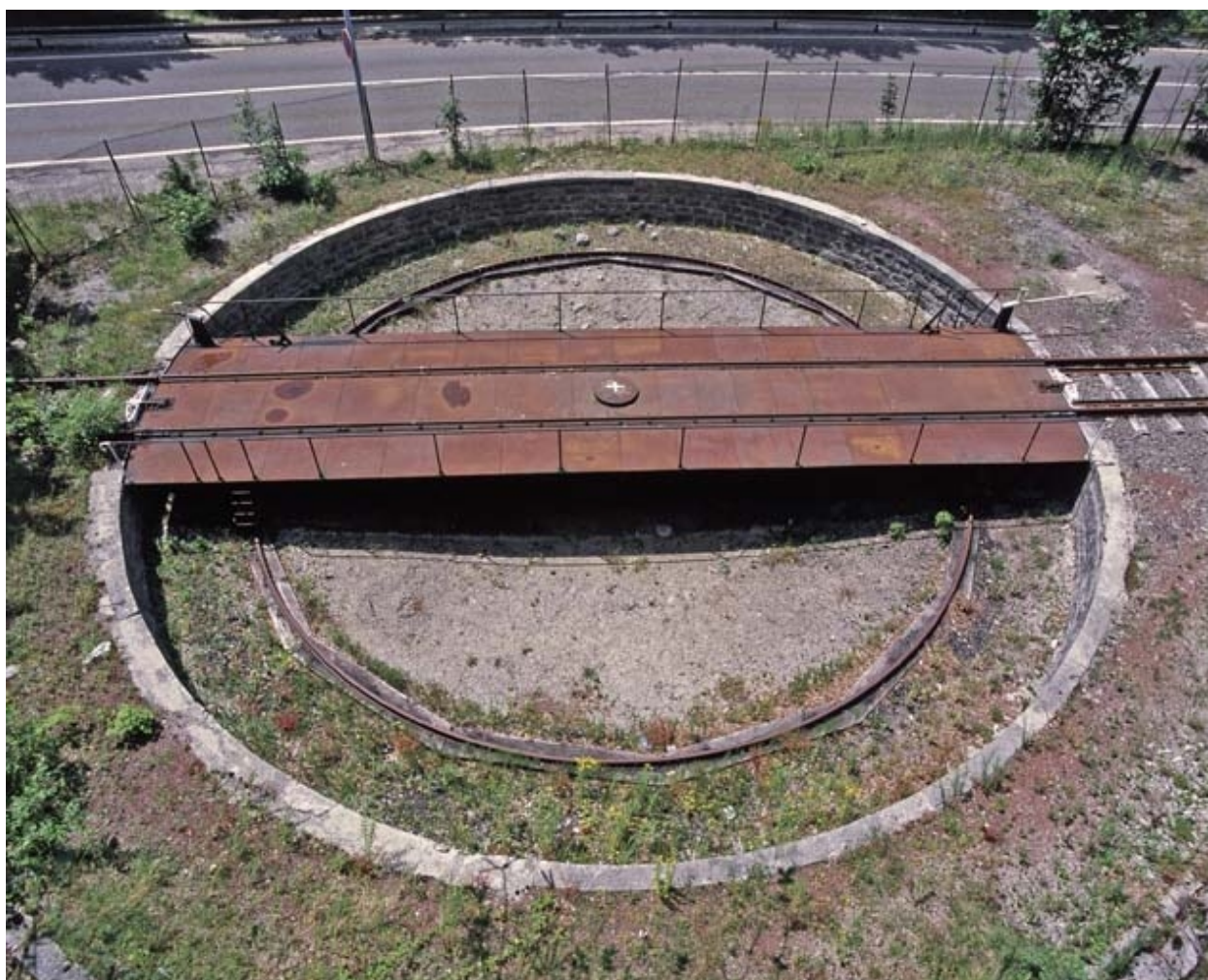
Vue d'ensemble plongeante, depuis l'est.
