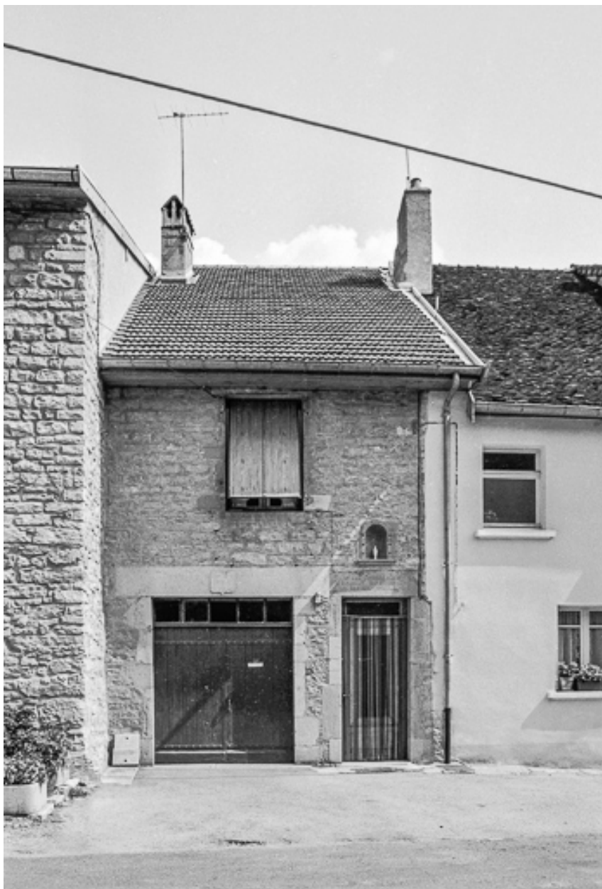
Maison cadastrée AD 140 : façade antérieure.
