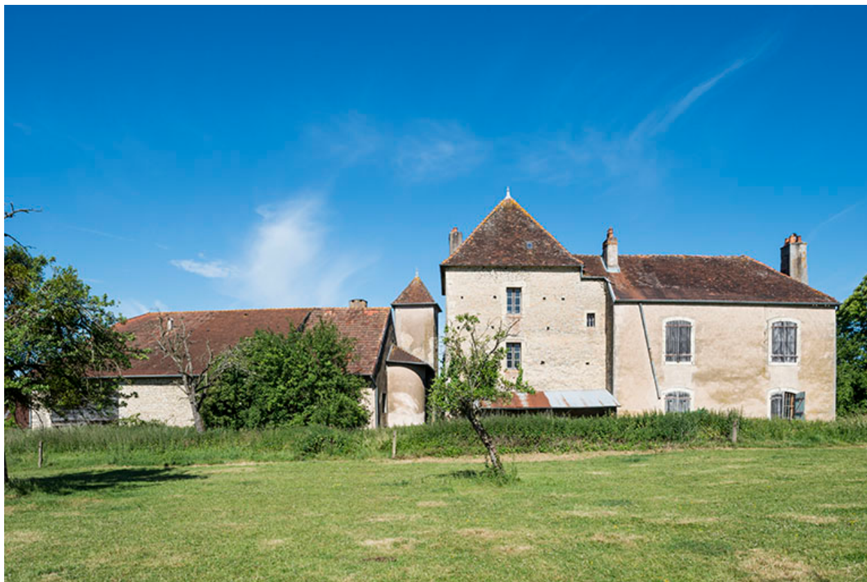
Vue d'ensemble de la façade postérieure.
