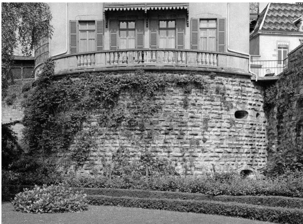
Tour sud-ouest depuis le fossé (1988).
