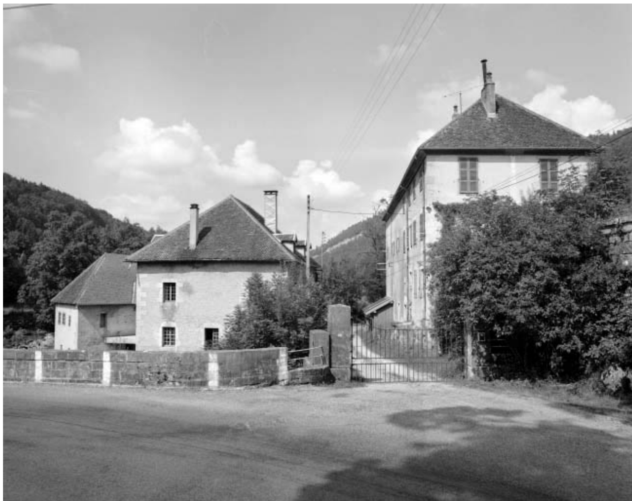
Entrée du site.
