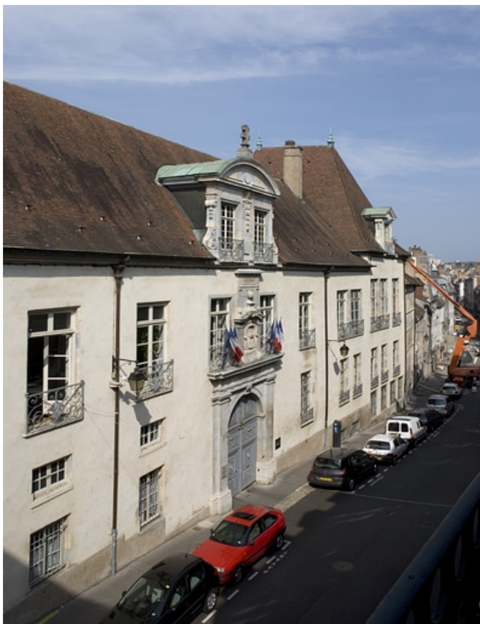
Façade sur rue, de trois quarts gauche.
