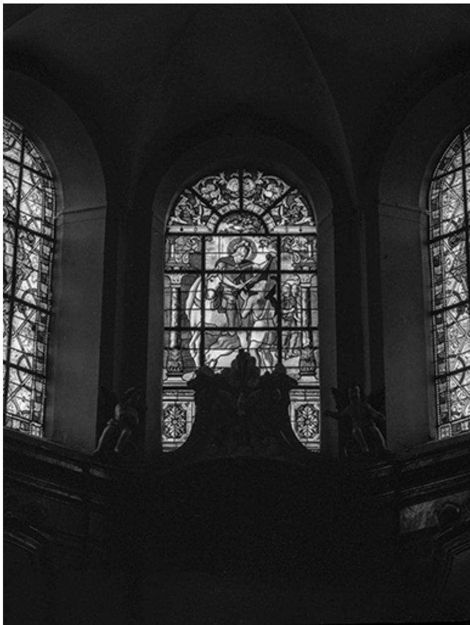
Baie 100 : vue d'ensemble.
