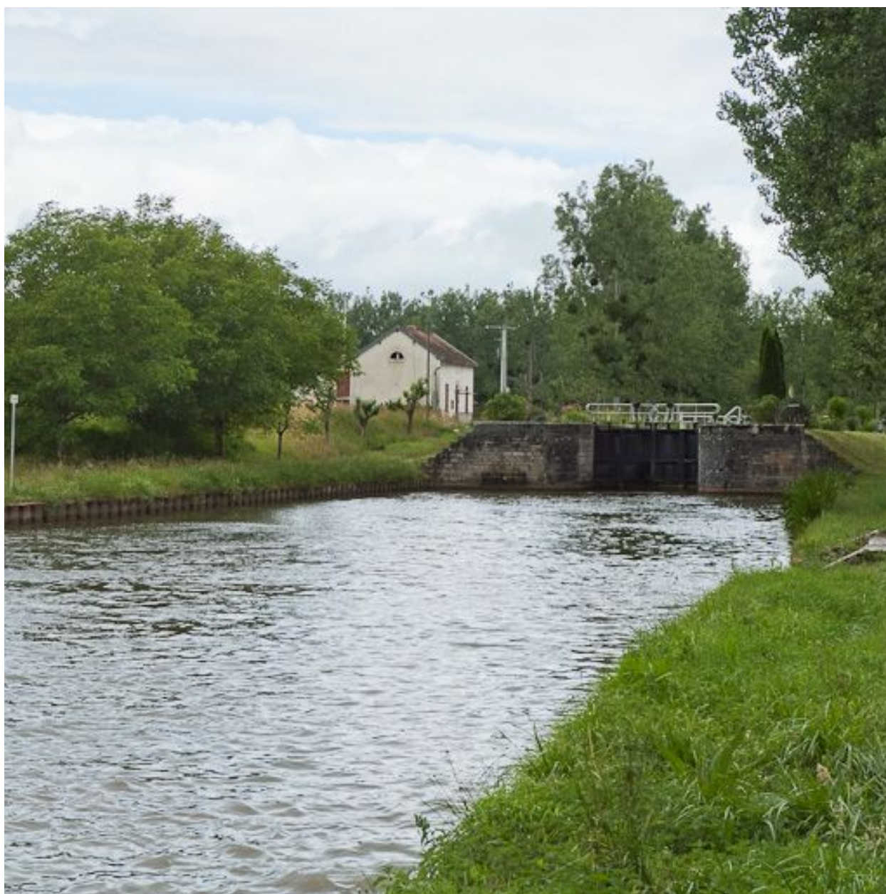
Site d'écluse vu depuis l'aval.
