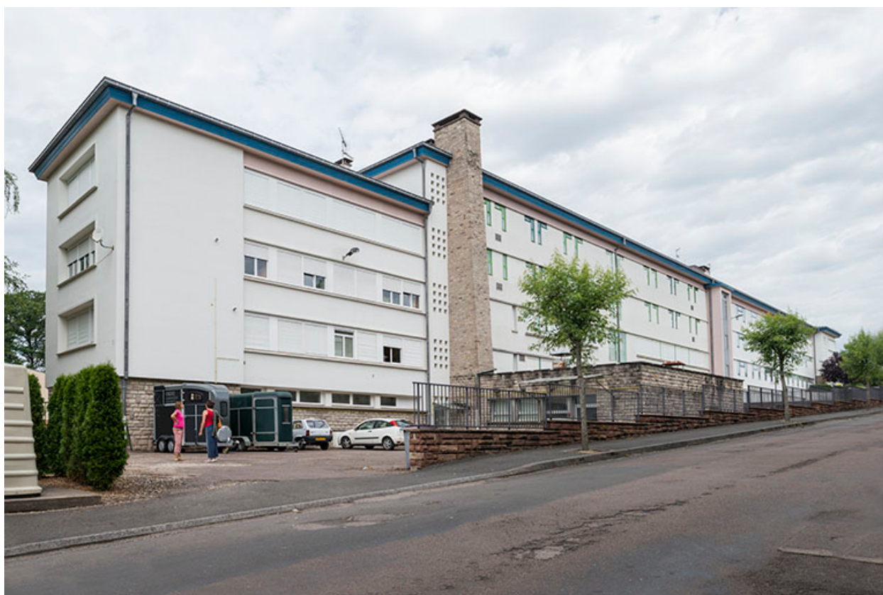
Externat et cuisine : façade antérieure, rue Rimey.
