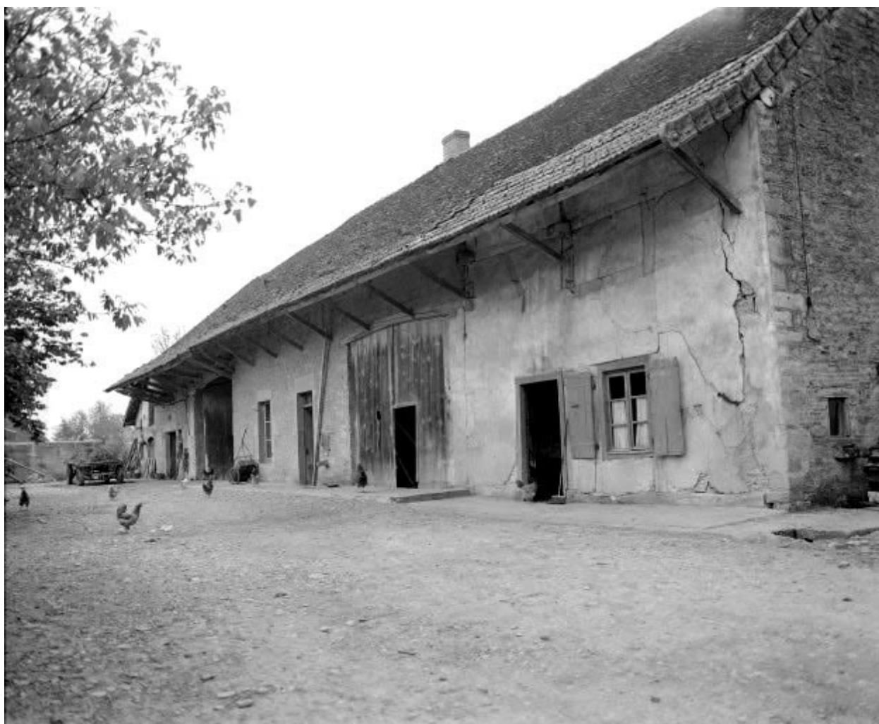
Ferme située rue de Beaurepaire.
