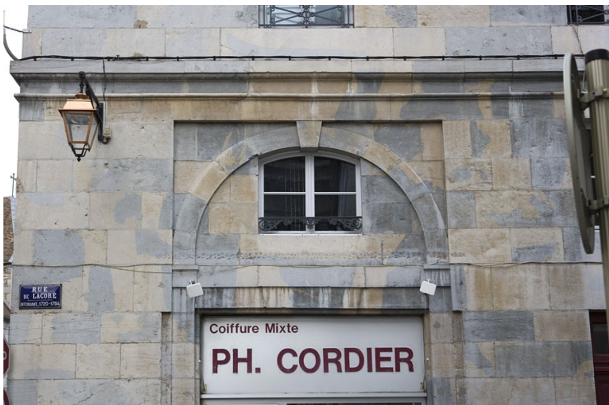
Détail d'une baie sur la rue secondaire.
