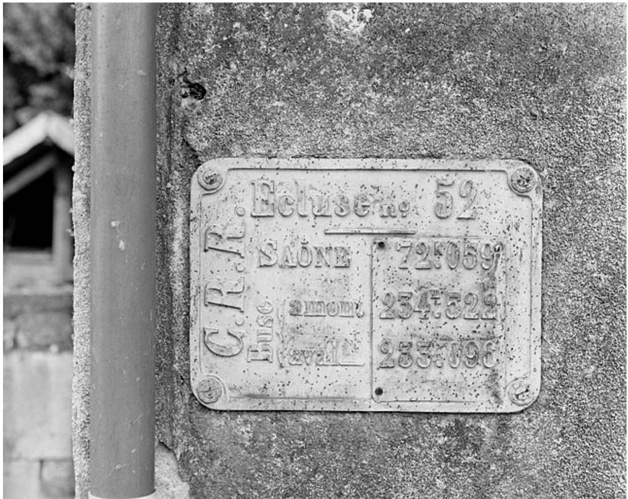
Plaque d'identification de l'écluse.
