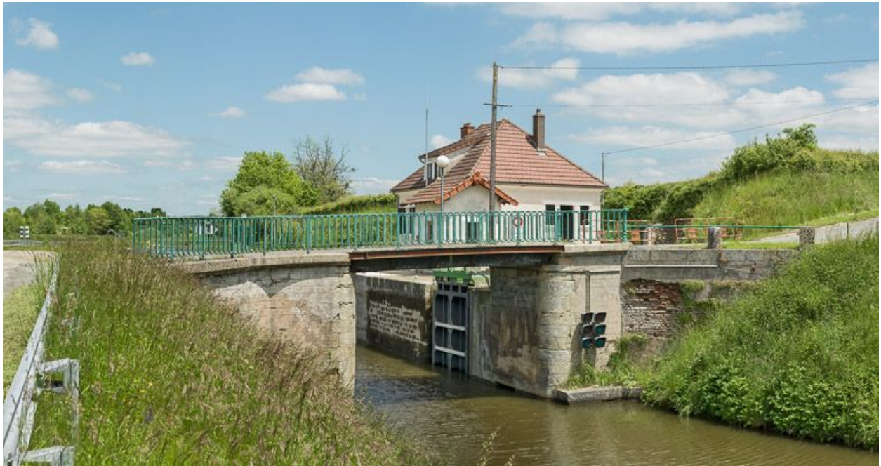
Vue d'aval du pont de Parisenot ou pont de Parizenot à Saint-Eusèbe.
