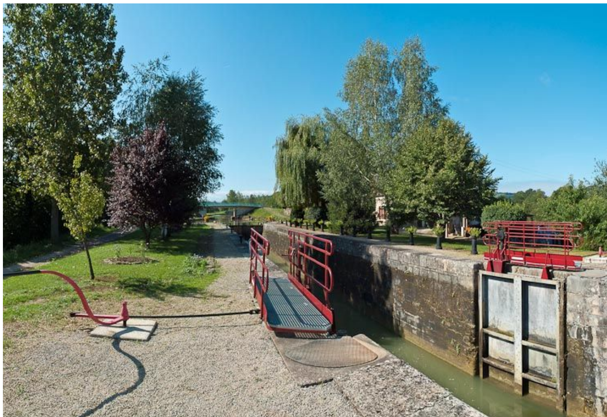
Vue du sas d'écluse.
