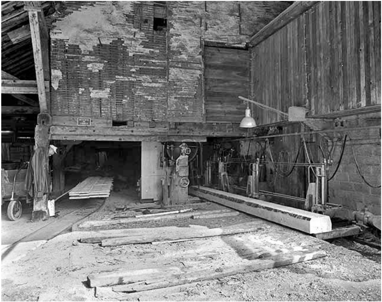
Intérieur de l'atelier de sciage.
