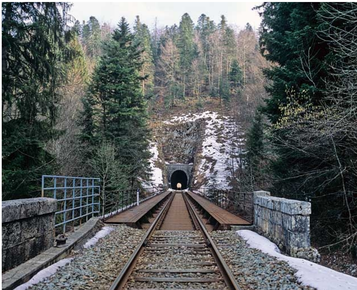
Vue d'ensemble depuis la voie, côté Andelot-en-Montagne.
