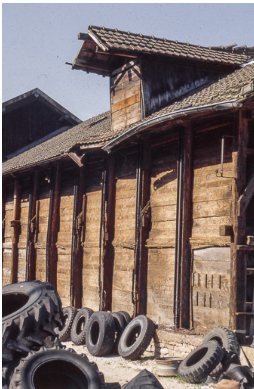
Détail de façade d'un magasin industriel.
