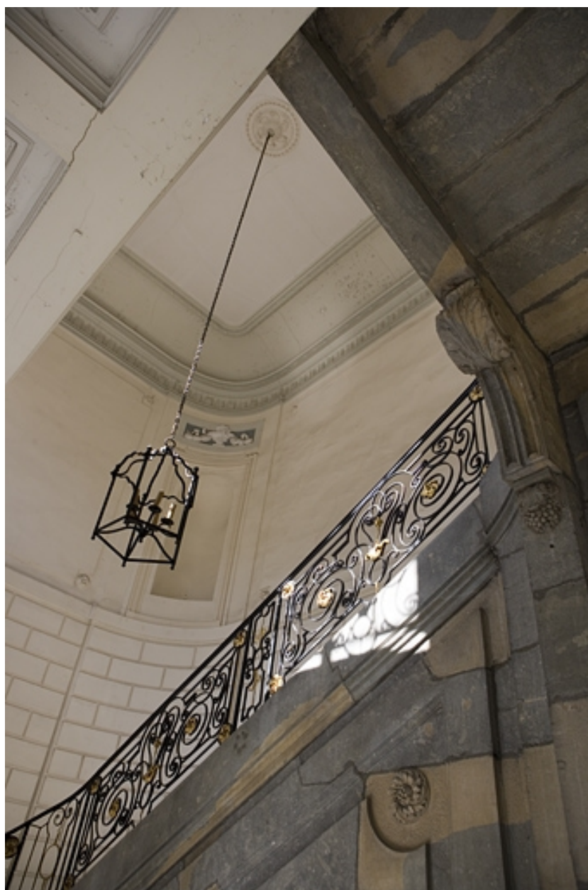
Escalier d'honneur : vue en contre-plongée.
