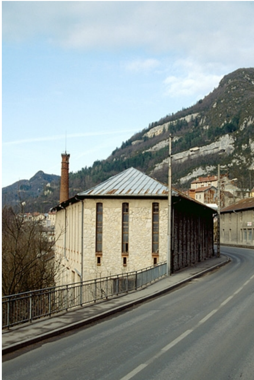
Façade latérale gauche du séchoir à ébauchons.
