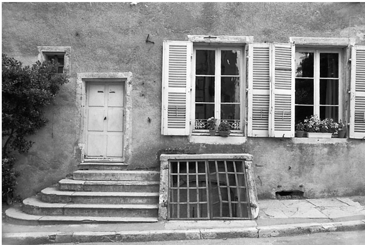
Détail du rez-de-chaussée.
