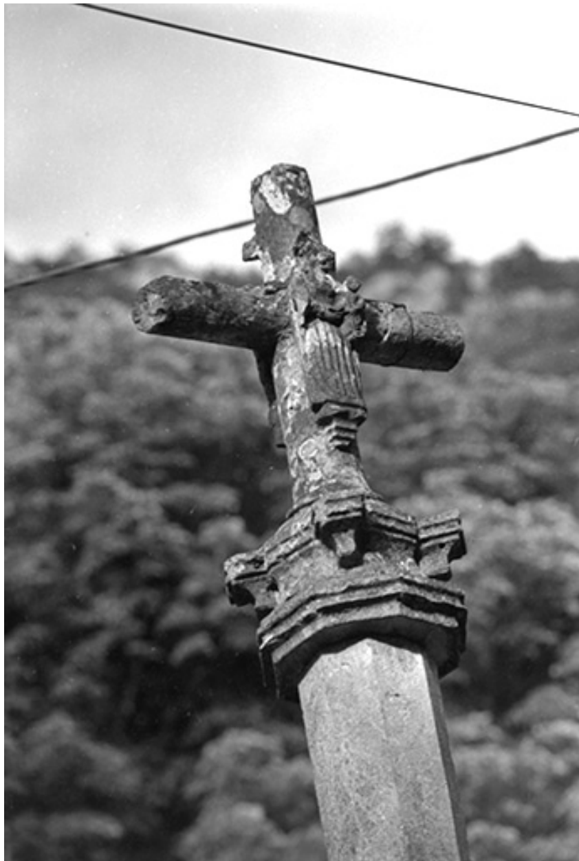
Croix monumentale : détail de la partie supérieure.
