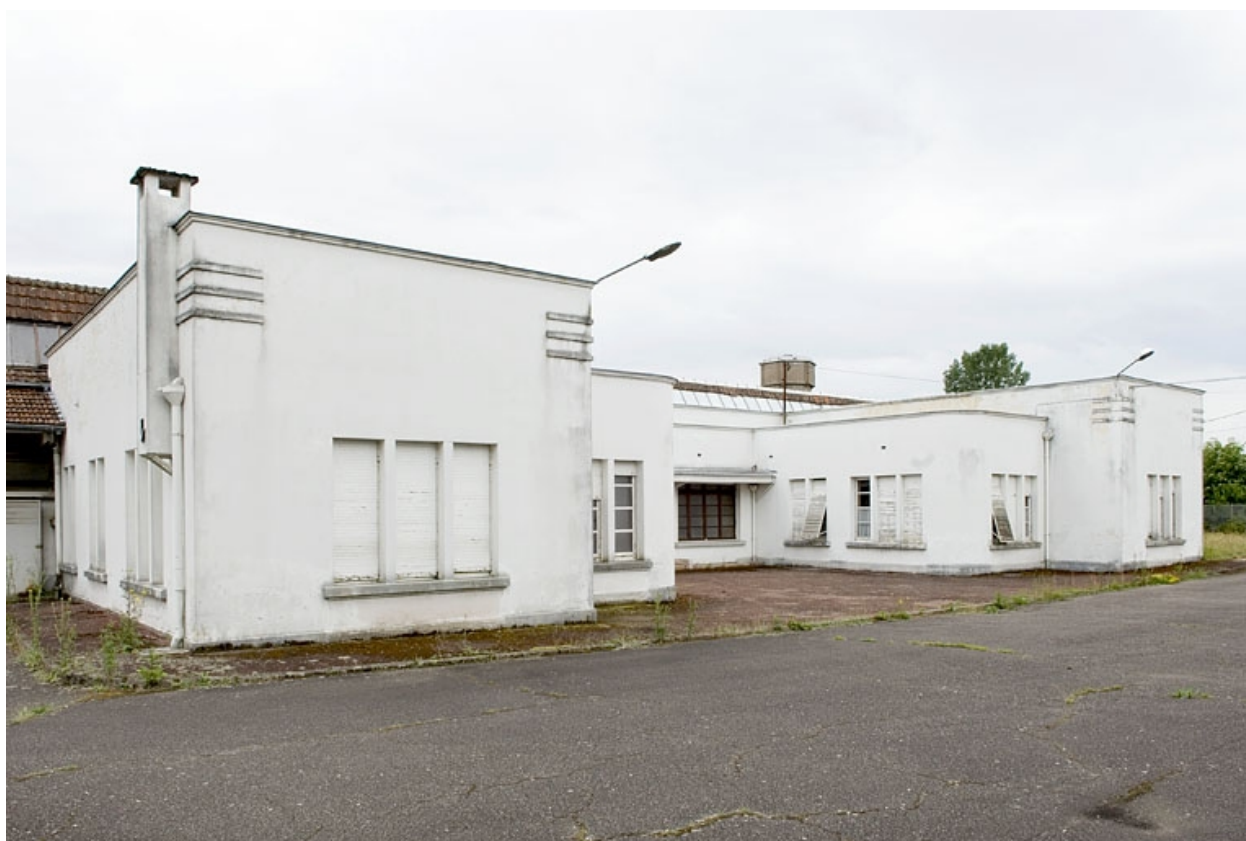
Les bureaux. Vue de trois quarts gauche.
